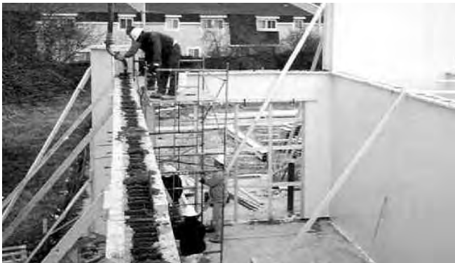
12.1a Concrete Pour in Progress
